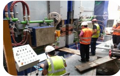
Instalaciones Industriales Eléctricas
