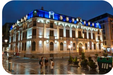
Instalaciones Terciarias Eléctricas
